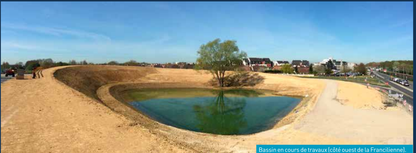
Bassin en cours de travaux (côté ouest de la Francilienne).
