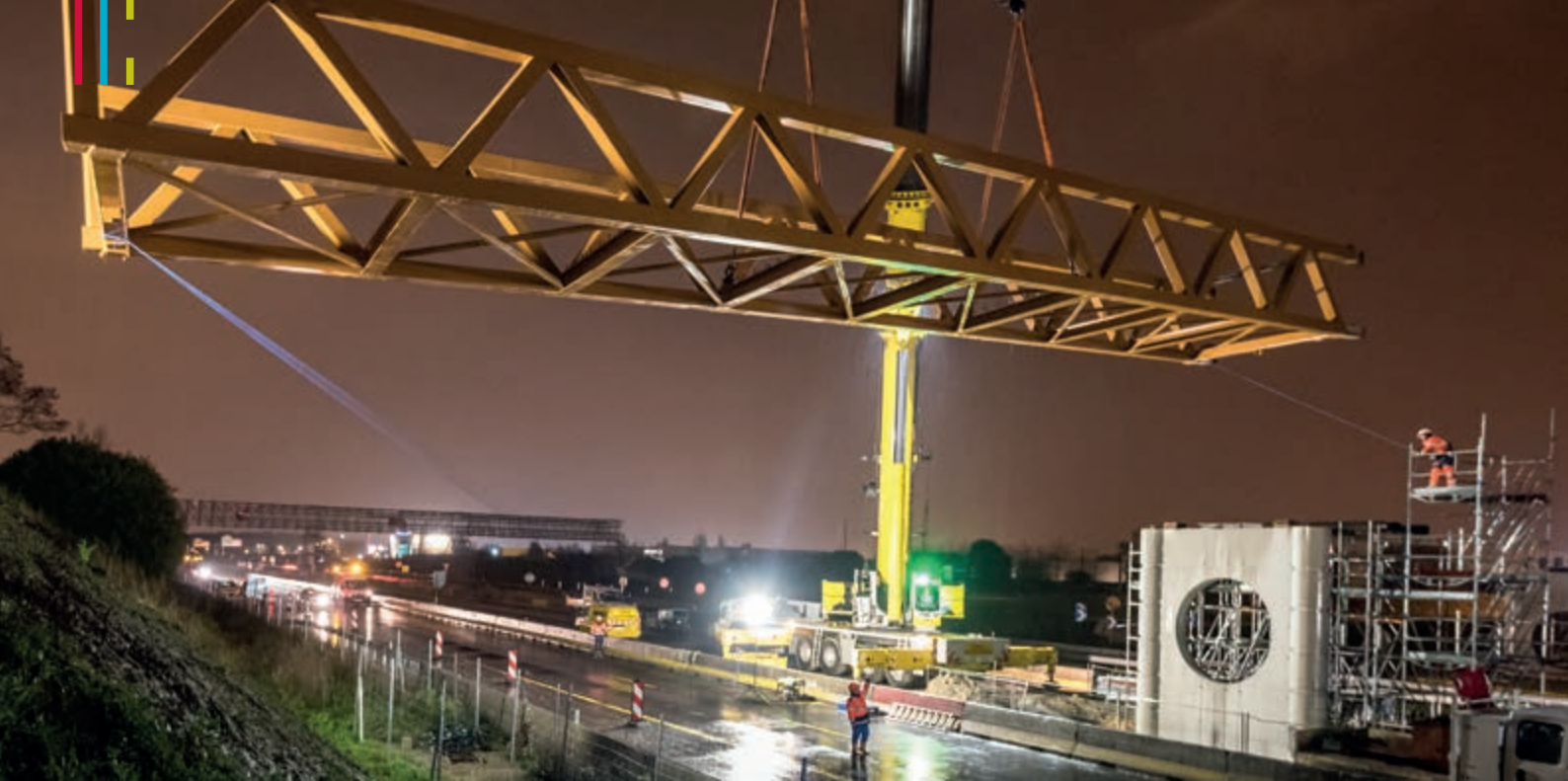
Mise en place de la nouvelle passerelle des Berchères
