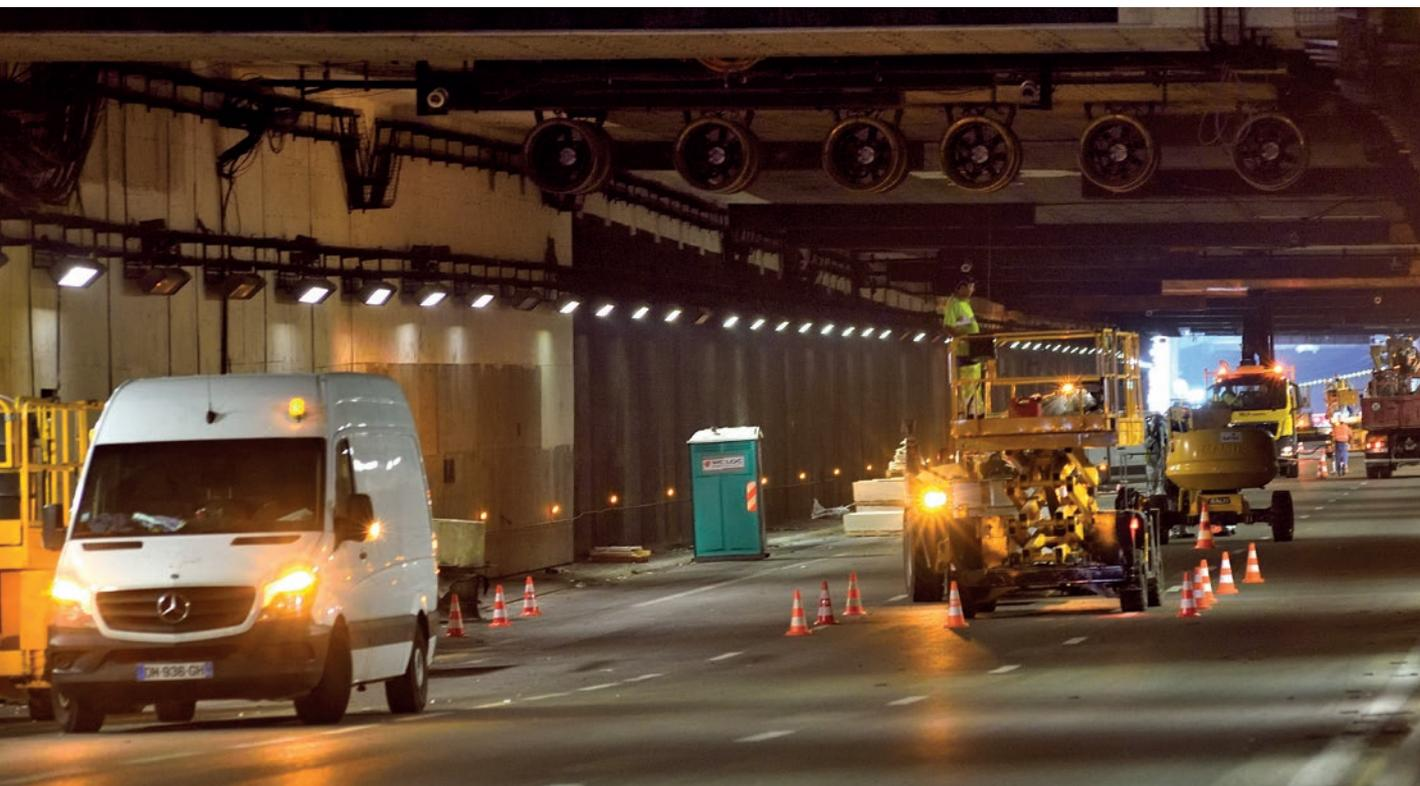
Installation de nouveaux blocs de ventilation dans le tunnel de Bobigny – Août 2018
