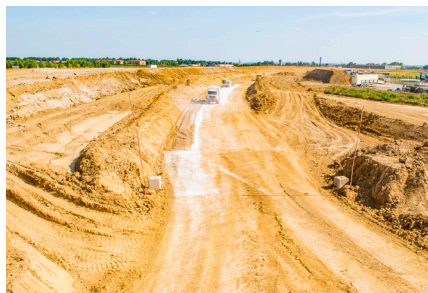
Terrassement pour le Contournement Est de Roissy.
