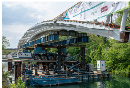
Pose d'une travée de la passerelle piétons-cycles du pont de Nogent.
