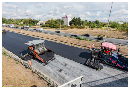
Rénovation des chaussées de la Francilienne..
