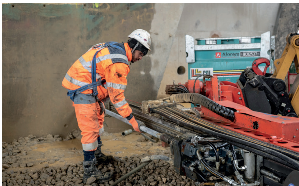
Mise en place de clous sur un mur de confortement (A15 Argenteuil)
