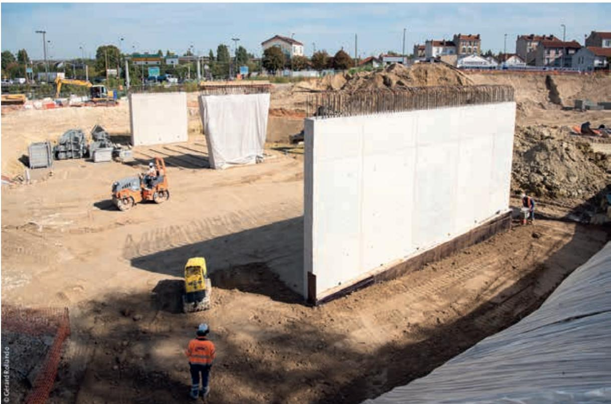
*Construction des piles de la passerelle paysagère au-dessus de la bretelle en boucle en 2018*
