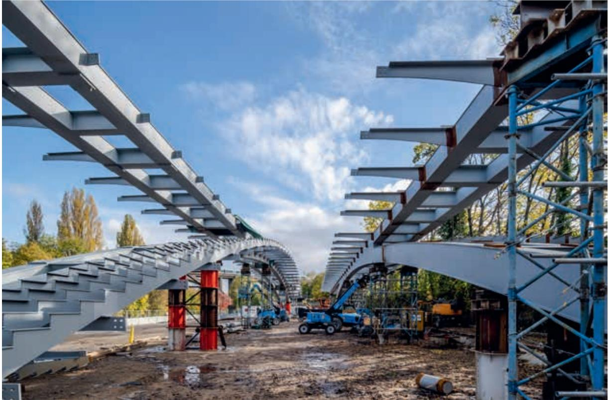
*Travaux d'assemblage des travées de la passerelle à Nogent en 2021*
