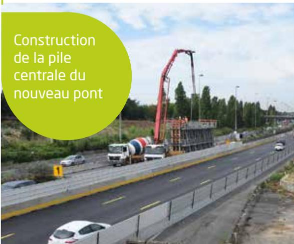
Construction de la pile centrale du nouveau pont
