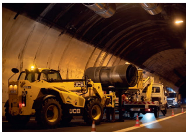
Inspection réglementaire du tunnel de 2024
