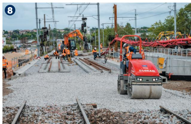
8 Compactage du ballast puis remise en place des voies ferrées
