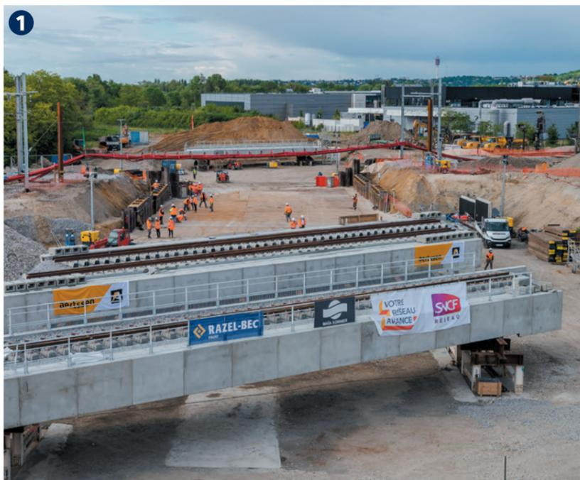
1 Tabliers préalablement assemblés sur site en attente d'être installés sur les appuis provisoires
