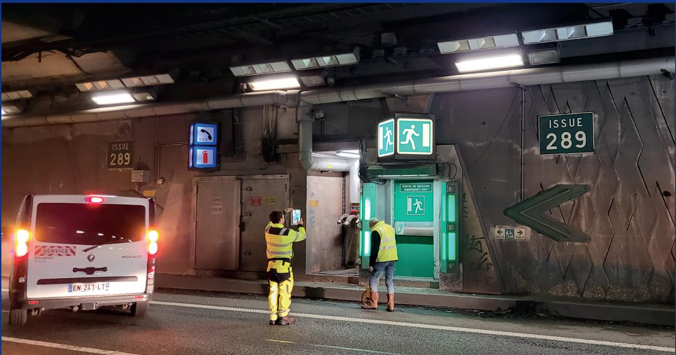
*Inspection détaillée périodique (IDP) en tunnel - Contrôle des issues de secours*
