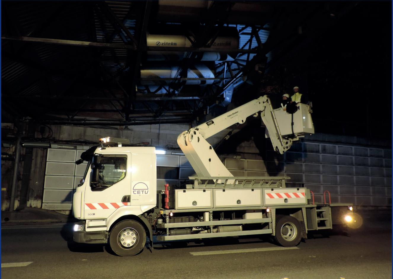
*Inspection détaillée périodique (IDP) en tunnel - Inspection des ventilateurs d'évacuation*
