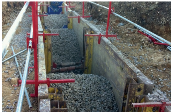
Tranchée drainante avant remblaiement
