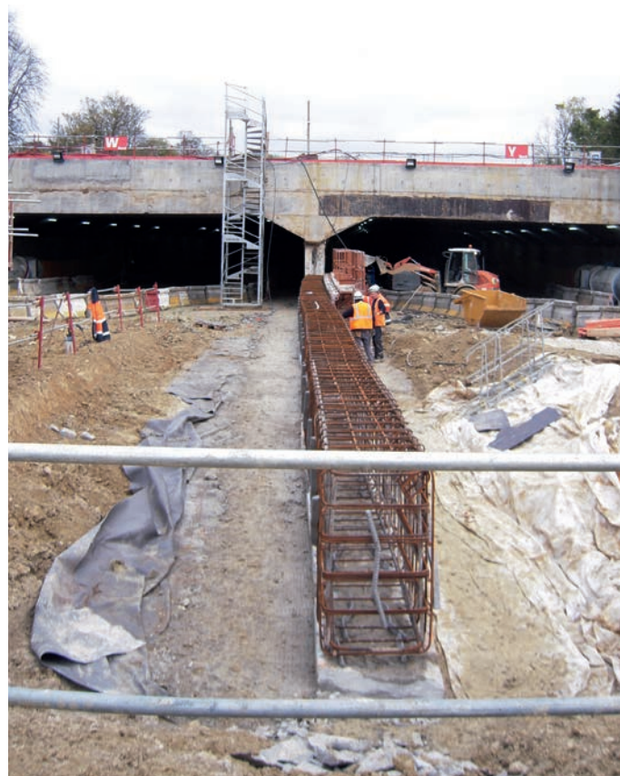
Accès Nord de la tranchée couverte
